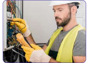
विज्जुकम्पी विद्युत्कर्मी-Electrician बिजली कर्मचारी
